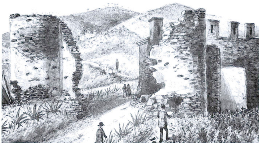
FIGURA 7. Torre de Bellesguard.
